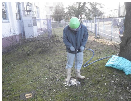
写真 10 左) 土壌灌注器 右) 土壌灌注の作業中
